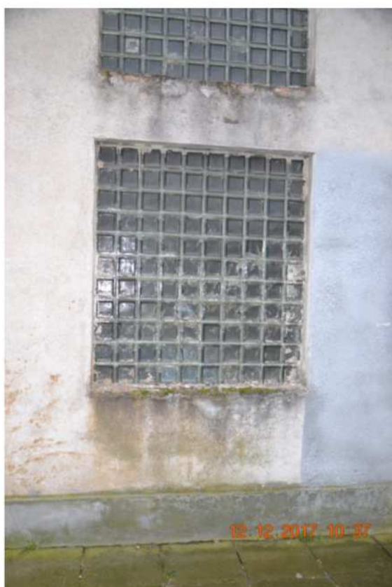
Fot. 15 Od strony drukarni - zniszczone pustaki szklane. Stan techniczny - ZŁY.
