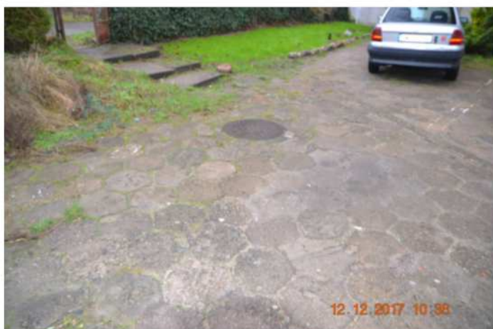
Fot.17 Plac z Trylinki przed budynkiem. Stan techniczny - ZŁY.
