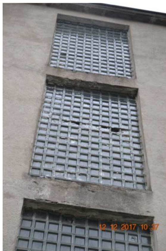
Fot.16 Zniszczone pustaki szklane na I pietrze.
